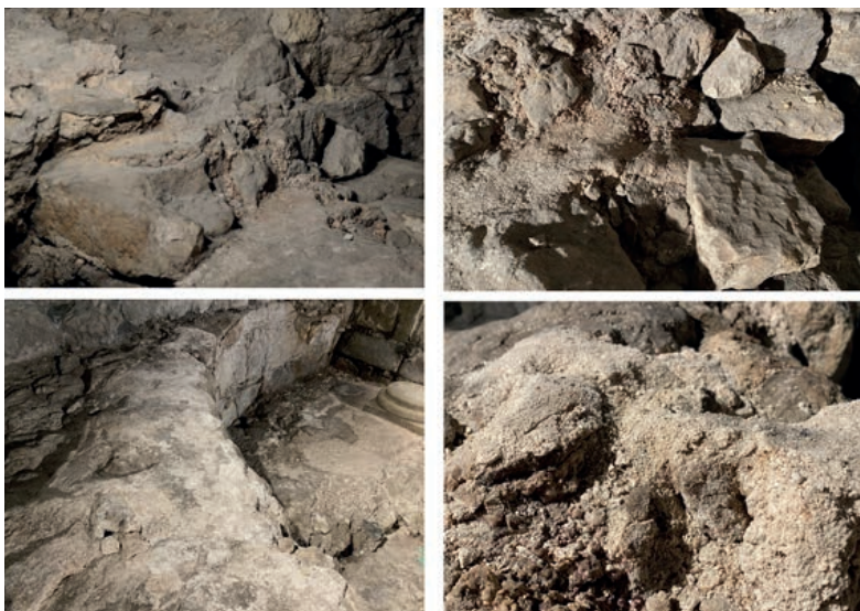
Fot. 1–4. Stan zachowania reliktów I kościoła romańskiego. Widoczne zniszczenia zaprawy z gipsu jastrychowego: rozkład, osypywanie się, rekrytalizacja oraz silne zanieczyszczenie wszystkich powierzchni, 2020, fot. M. Stec
