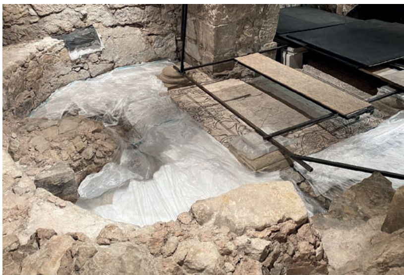
Fot. 17. Posadzka krypty I kościoła romańskiego podczas zabiegu impregnacji stężoną wodą gipsową, 2021, fot. M. Stec
