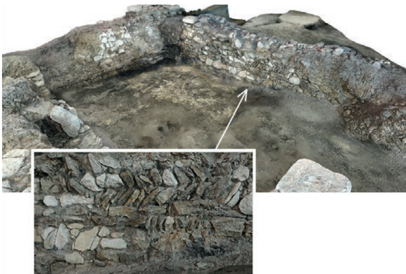
Il. 25. Kościół św. Mikołaja, północno-zachodni wewnętrzny narożnik z widocznym wątkiem opus spicatum w dolnej części fundamentu. Obraz wygenerowany z modelu 3D, wyk. A. Gołębniak, I. Żyła-Sutkowska
