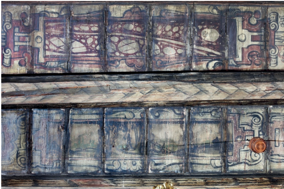
Fot. 6. Pęknięcia drewna zaklejone paskami płótna (od lewej) i papieru (w centrum kadru) znajdujące się na belce (nr 15), fot. Paweł Suchanek
