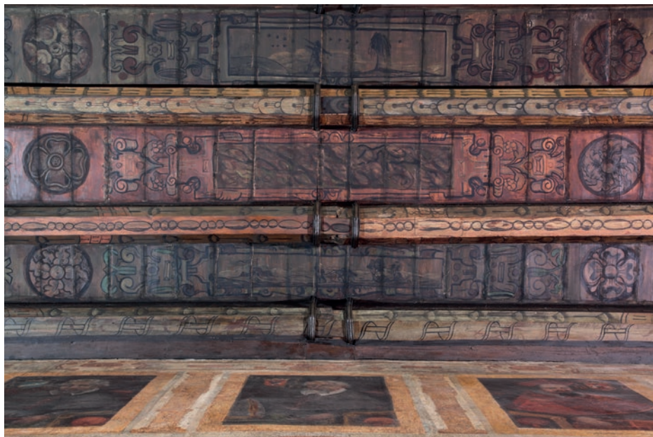
Fot. 8. Fragment z trzema wtórnymi belkami. Widoczne łączenie belek pod metalowymi okuciami, fot. Paweł Suchanek
