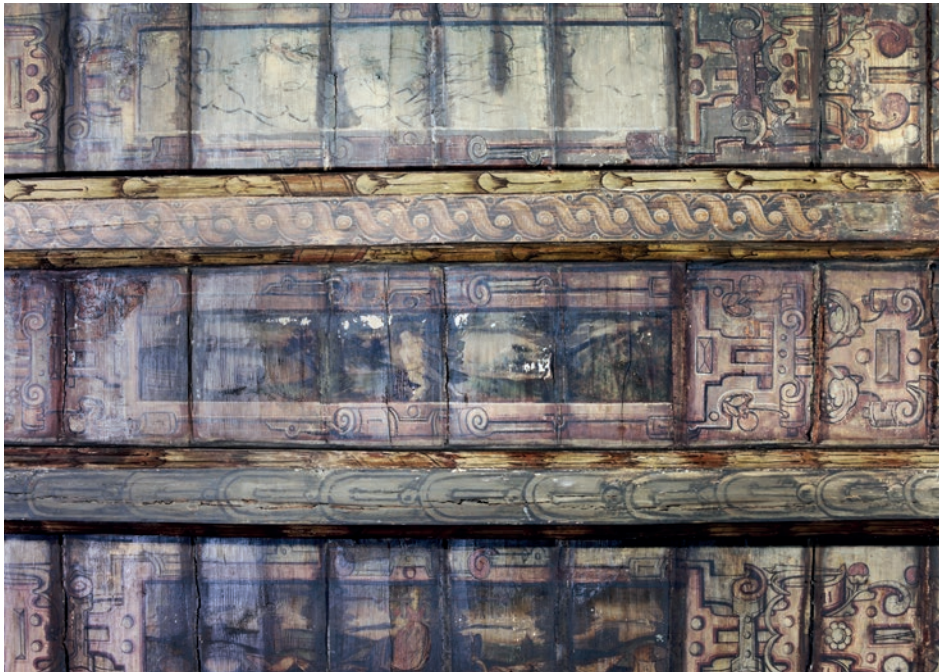
Fot. 4. Fragment stropu z czytelnymi przemalowaniami w prawym górnym narożniku, fot. Paweł Suchanek
