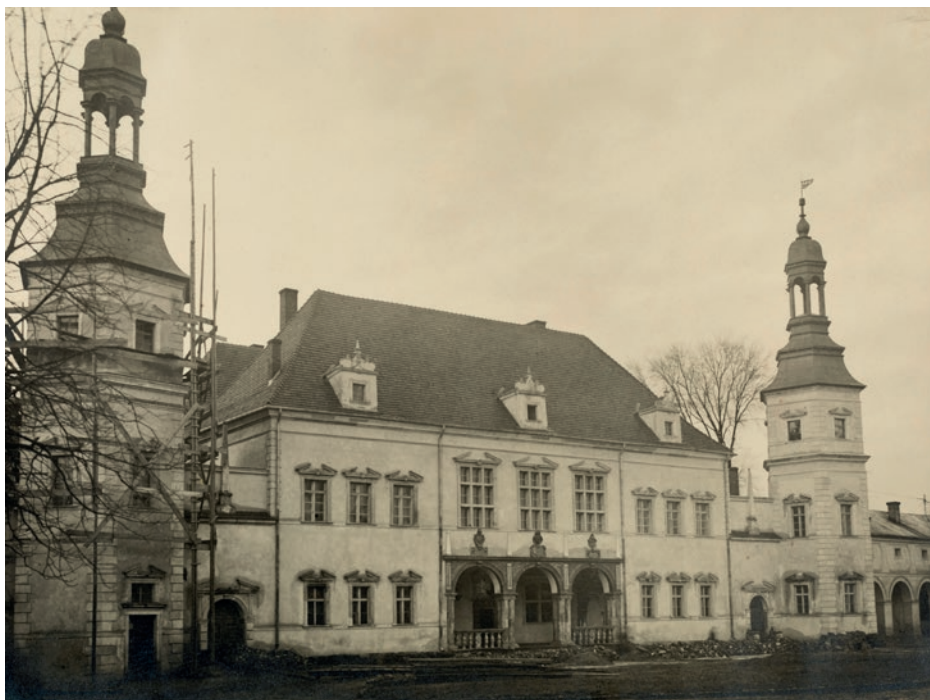
Il. 15. Fasada pałacu, zrekonstruowane hełmy wież od strony dziedzińca i remont dziedzińca z budową schodów przed loggią, 1928, Muzeum Narodowe w Kielcach
