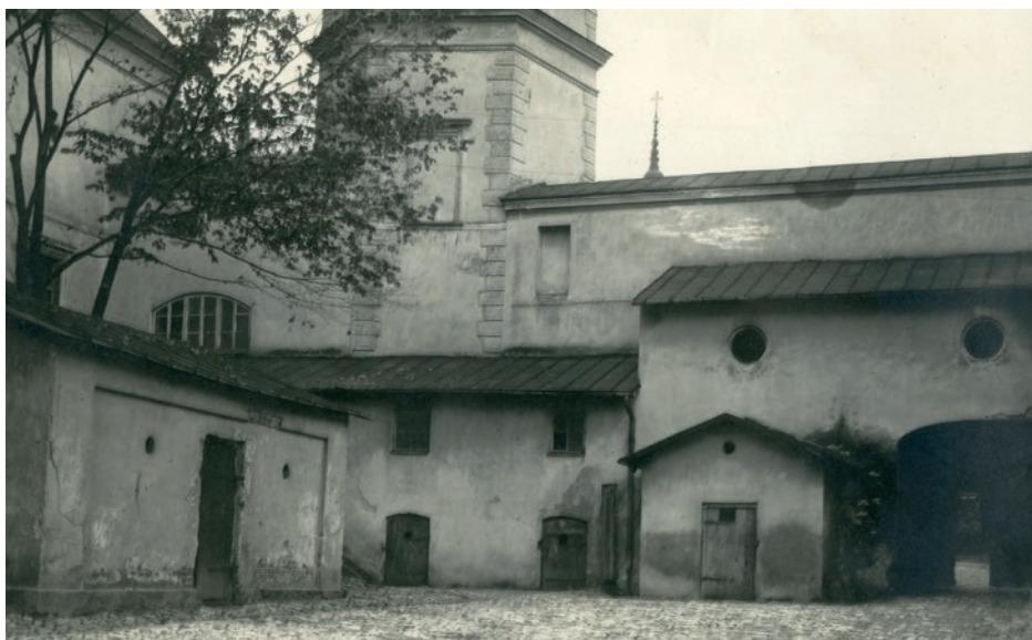
Il. 9. Przybudówka od strony dziedzińca południowego, prowadząca z wieży południowo-wschodniej na podest historycznej klatki schodowej, ok. 1919–1922, Wojewódzki Urząd Ochrony Zabytków w Kielcach, nr 5903
