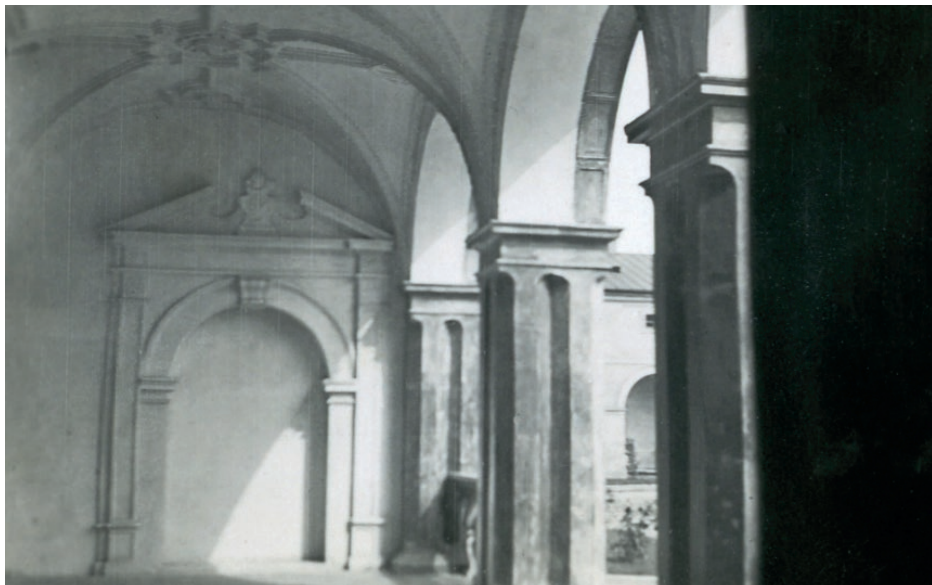
Il. 8. Portal w północnej ścianie loggii wejściowej, ok. 1919–1936, Wojewódzki Urząd Ochrony Zabytków w Kielcach, nr 14.754
