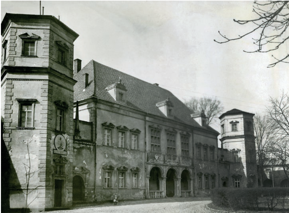
Il. 6. Front pałacu z wejściem w wieży południowo-wschodniej, nad którym widoczne jest godło Polski, zatwierdzone przez Sejm Ustawodawczy 1 sierpnia 1919 roku, 1919–1922, Wojewódzki Urząd Ochrony Zabytków w Kielcach, nr 4944
