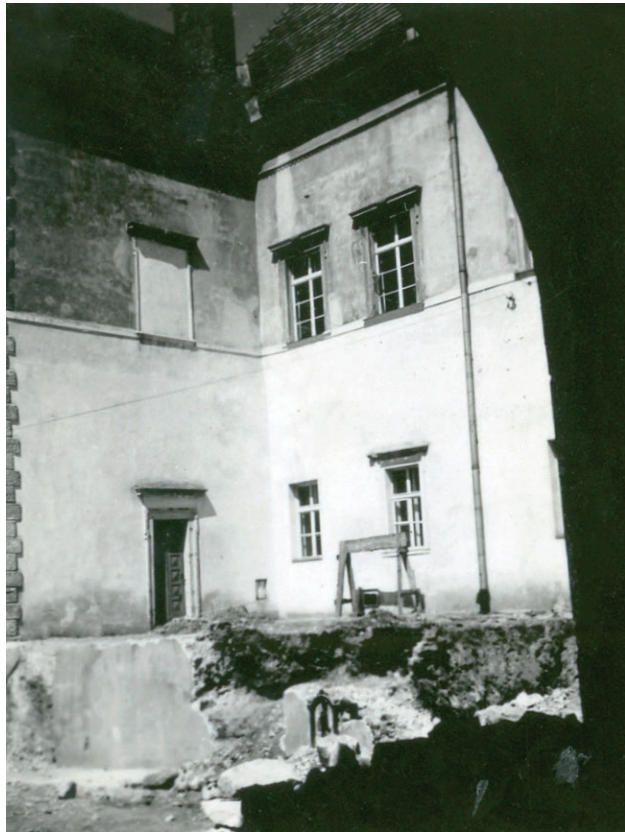
Il. 37. Budowa nowego tarasu przy południowej fasadzie pałacu do przygotowywanej części muzealnej wraz z remontem elewacji, wstawianiem obramieniami okien na wzór dawnych oraz płyty nad wejściem z planowanym cytatem z Beniowskiego Juliusza Słowackiego, 1936–1937, Wojewódzki Urząd Ochrony Zabytków w Kielcach
